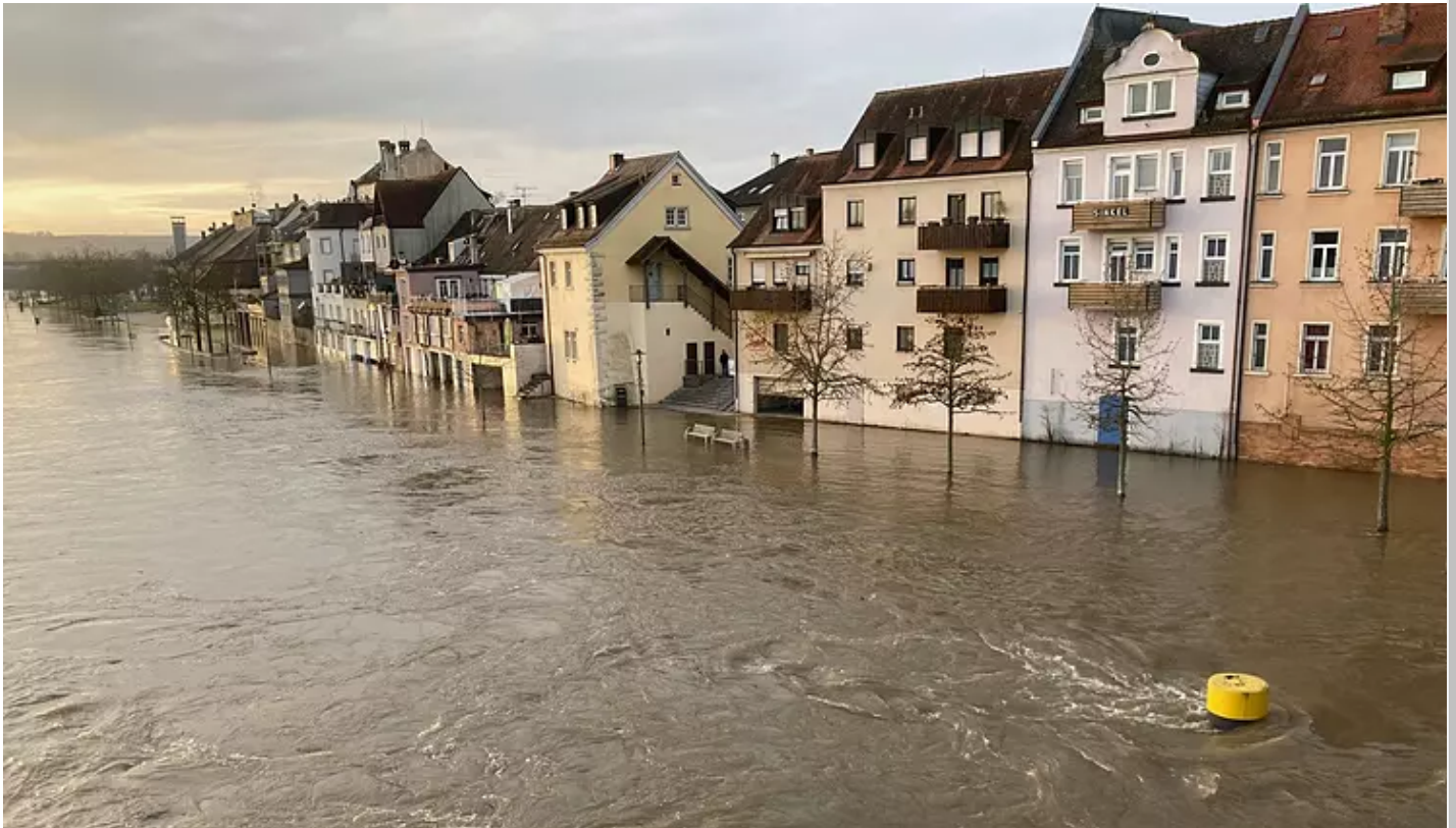
Foto: Diana Fuchs | Ende des Jahres 2023: Die gelben Aufprallschutz-Säulen an der Alten Mainbrücke in Kitzingen verschwinden fast vollständig im Hochwasser des Main.
